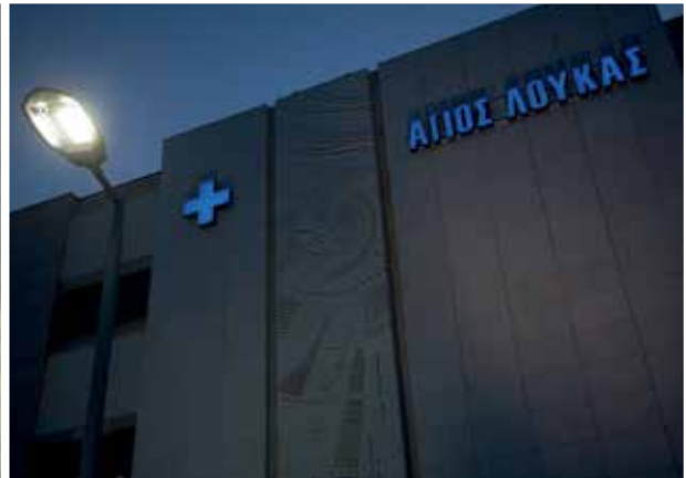
Saint Lukas Hospital. Outdoor lights application. Κλινική Άγιος Λουκάς. Εφαρμογή σε εξωτερικό χώρο.
