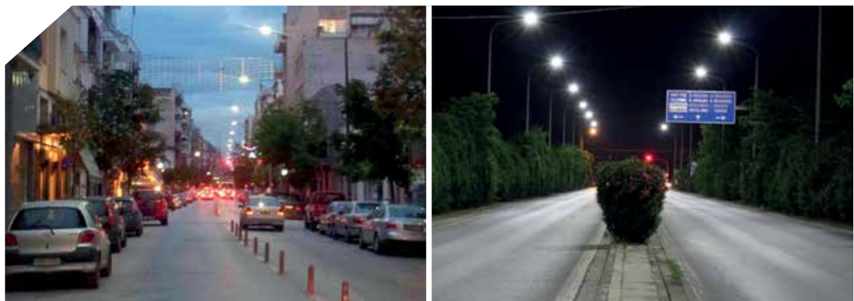
Municipality of Volos. Street lights application. Δήμος Βόλου. Εφαρμογή σε δρόμο.
