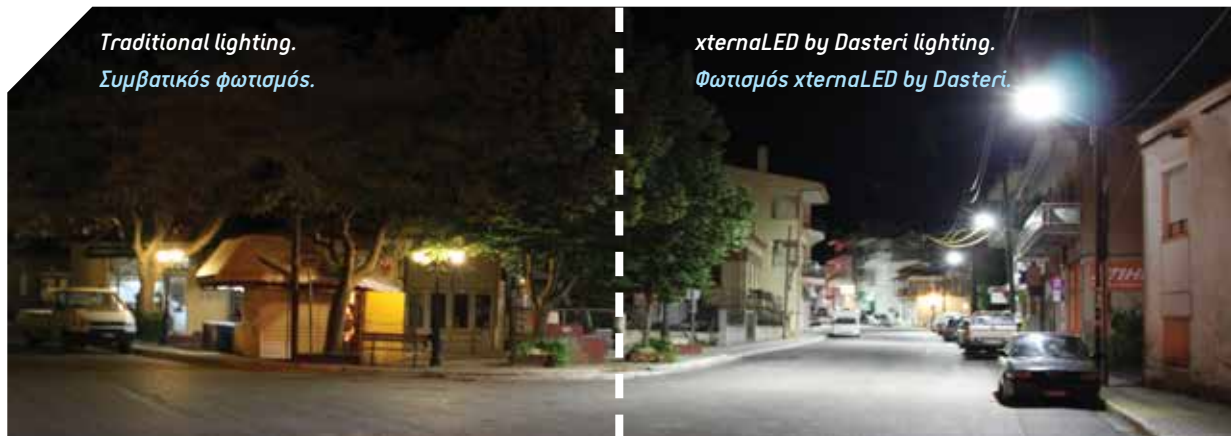
↳ Municipality of Maronia - Sapes. Street lights application. Δήμος Μαρωνείας - Σαπών. Εφαρμογή σε δρόμο.
