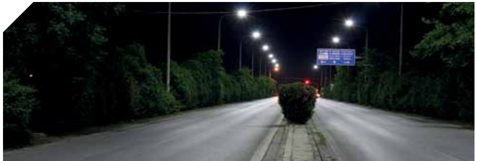
Part of street (A) with Dasteri LED Lighting Τμήμα δρόμου (Α) με Dasteri φωτιστικά Τύπου LED
